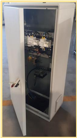
Elicity in un armadio in vetroresina IP65 da itinere, pressato a caldo, di colore grigio chiaro simile al RAL 7032 (inalterabile alle intemperie), autoestinguente, con porta completa di chiusura.
